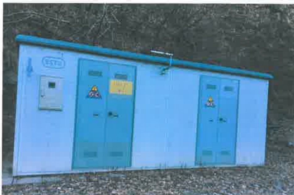
Fig. 10 Detaliu compartiment de racordare (partea stângă compartimentul ENEL DISTRIBUȚIE BANAT S.A., iar în partea dreaptă compartimentul producătorului)
