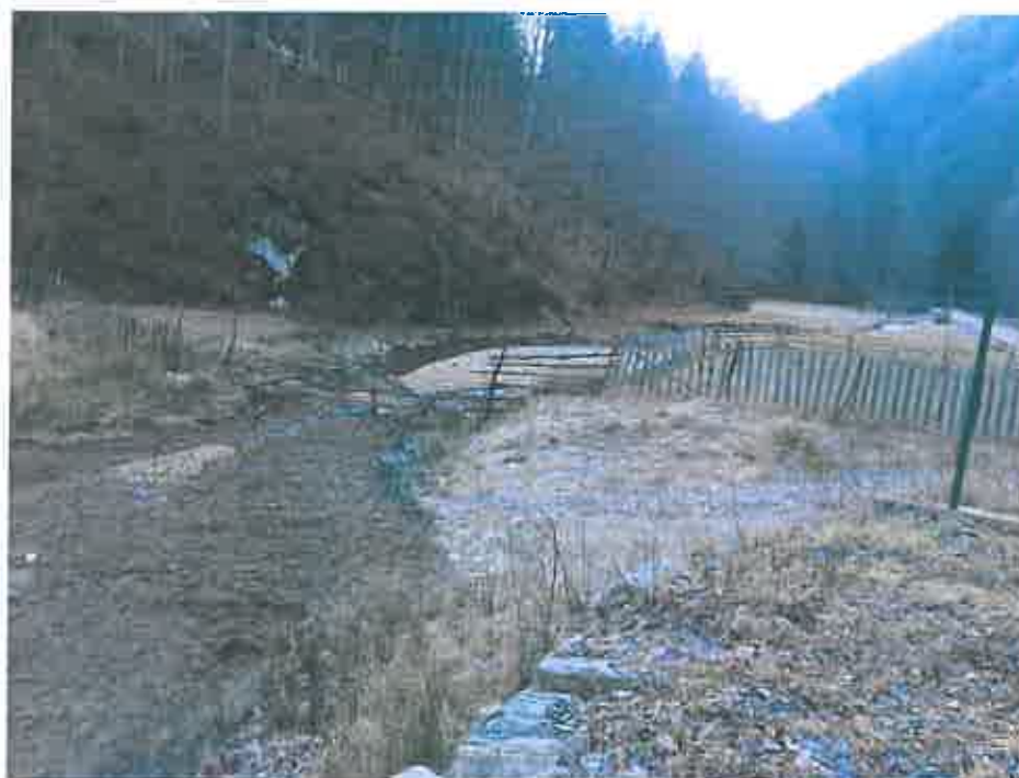
Fig. 4 Detaliu râul Taia, aval de captarea Taia
