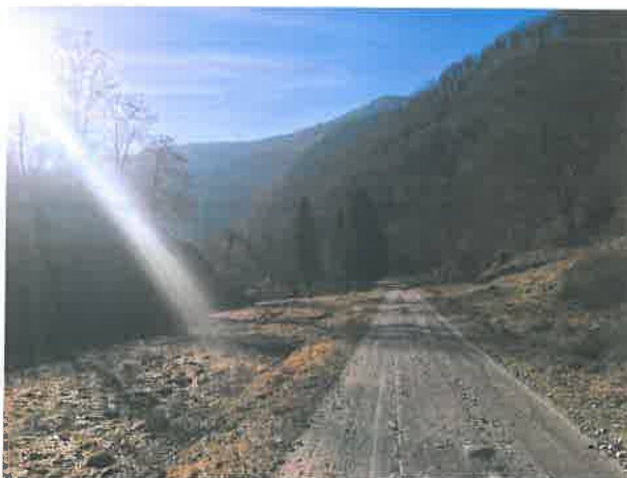
Fig. 15 Detaliu conductă de aducțiune îngropată captare Aușel (conducă este amplasată în partea dreaptă a drumului, aval de captare, în partea stângă fiind râul Aușel)
