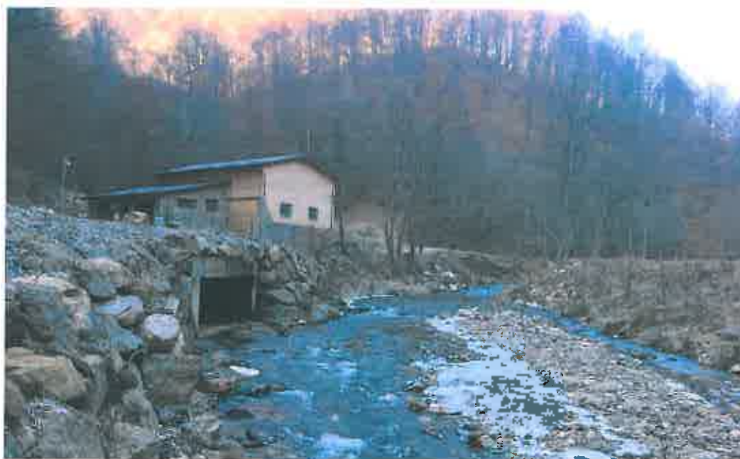
Fig. 11 Detaliu canal de debrușare
