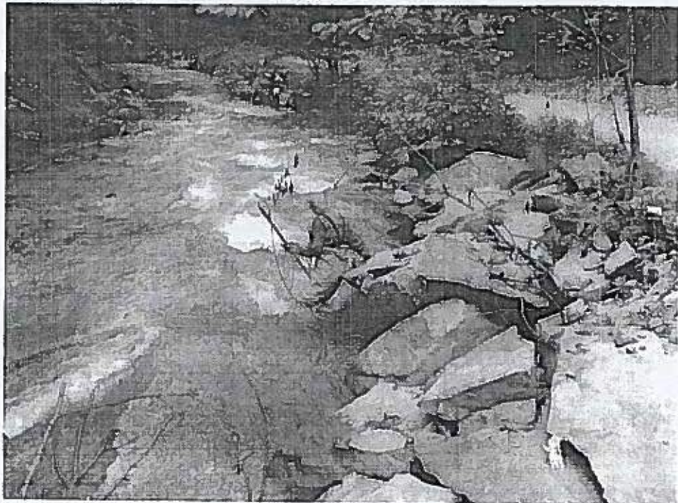
Foto 1.18. Stația Taia 4 aspect general, se observa consolidarea malului cu piatră
