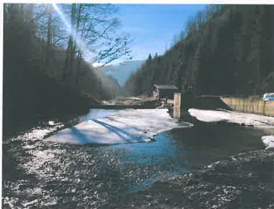
Fig. 6 Detaliu amonte captarea Aușel
