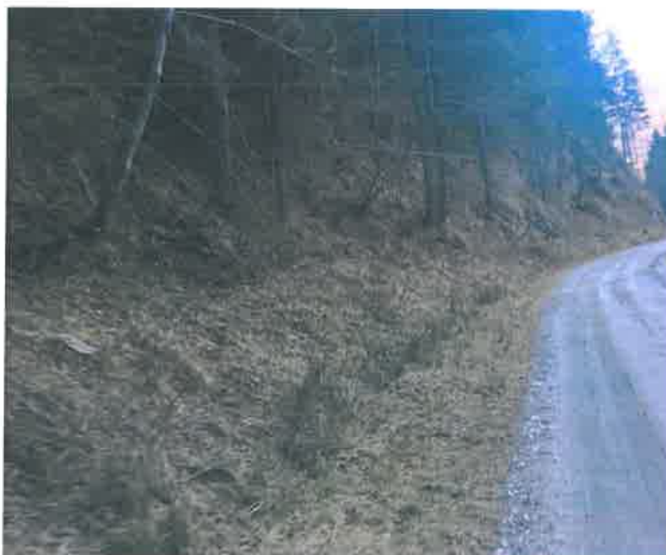
Fig. 13 Detaliu conductă de aducțiune îngropată captare Tia (conductă este amplasată în partea stângă a drumului, aval de captare)
