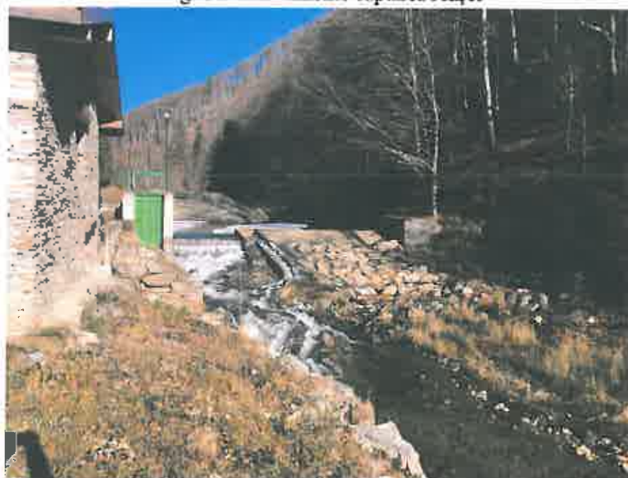
Fig. 7 Detaliu aval captare Aușel
