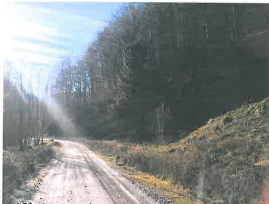
Fig. 14 Detaliu conductă de aducțiune îngropată captare Aușel (conducă este amplasată în partea dreaptă a drumului, aval de captare)
