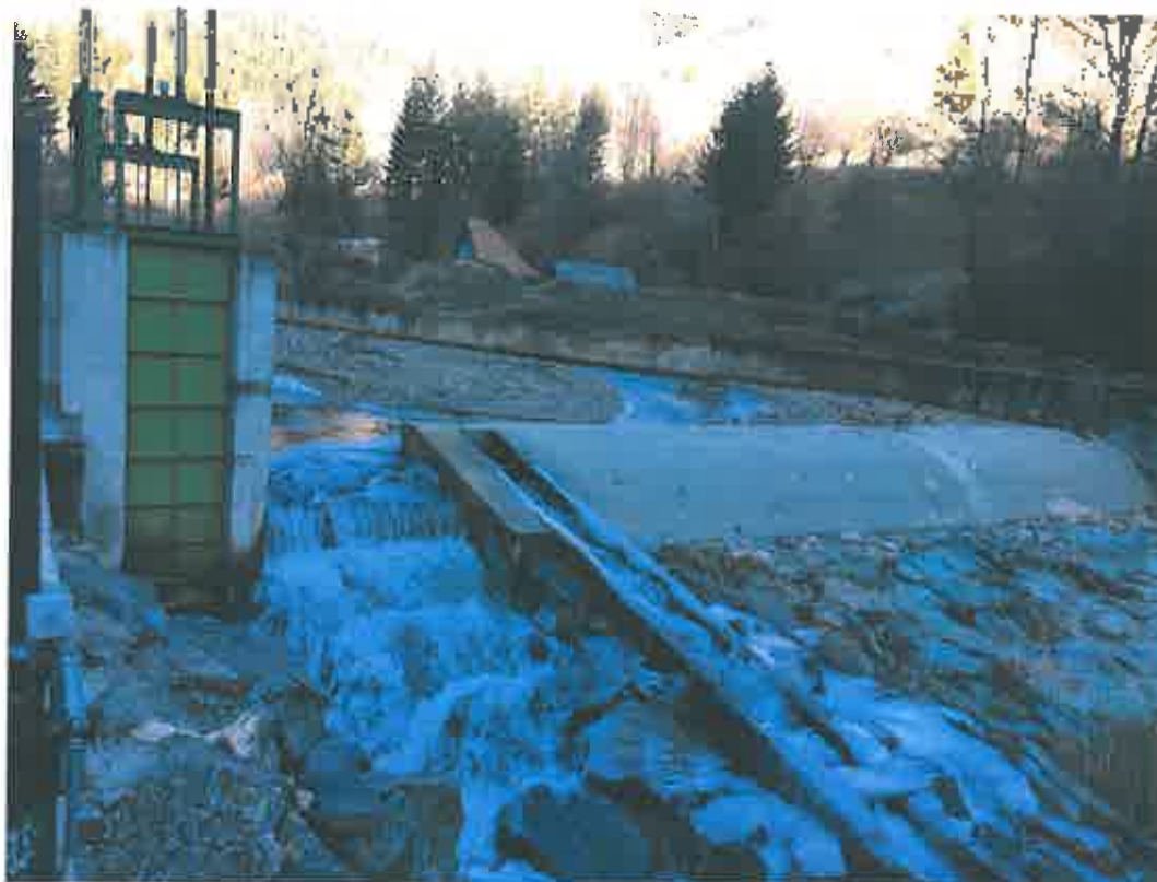
Fig. 2 Detaliu captare Taia
