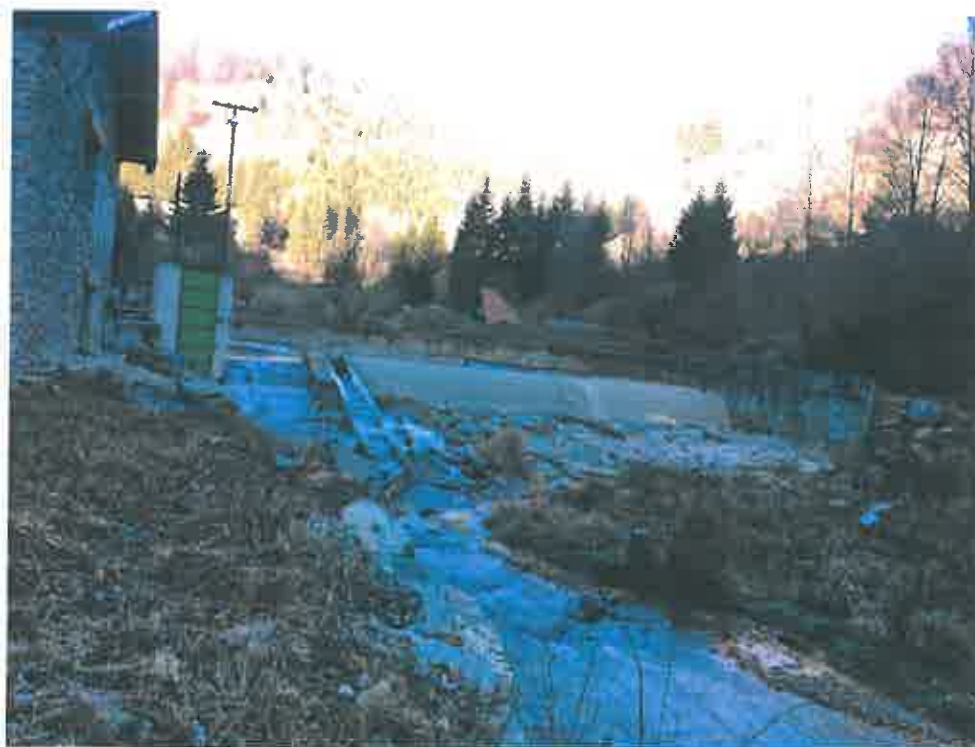
Fig. 3 Detaliu aval captare Taia
