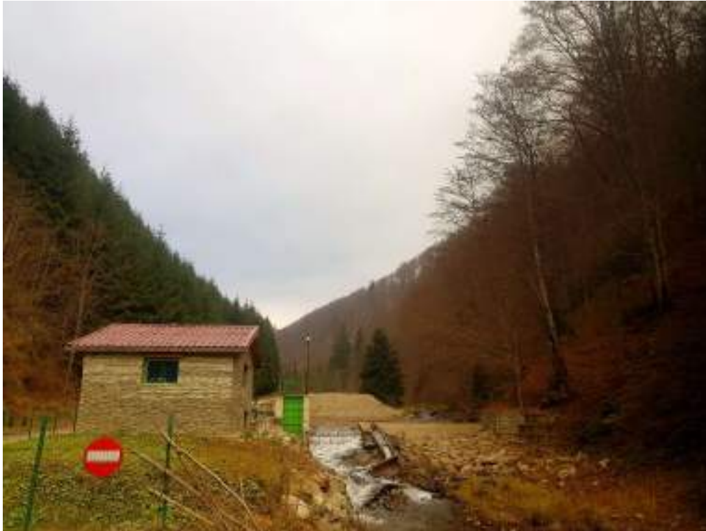
Fig.15. Habitate pescuite AUȘELU 3
