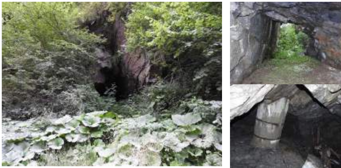
Fig. 32 Detalii galeria artificială nr. 4
