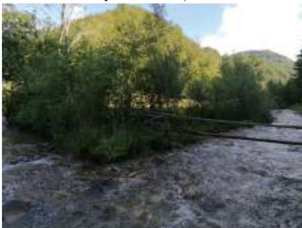
Aspecte din stația T4
