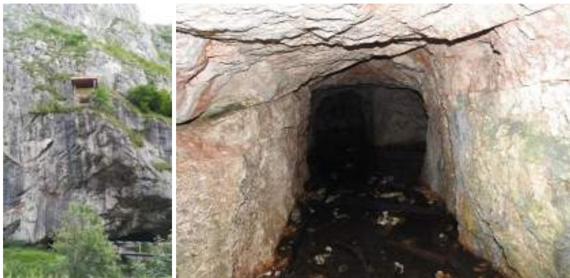
Fig. 27 Detalii galeria artificială nr. 2
