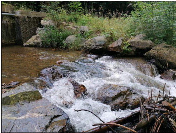
Aspecte din stația T3
