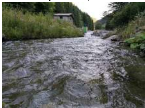
Aspecte din stația A1
