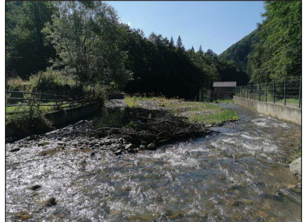
Aspecte din stația T2
