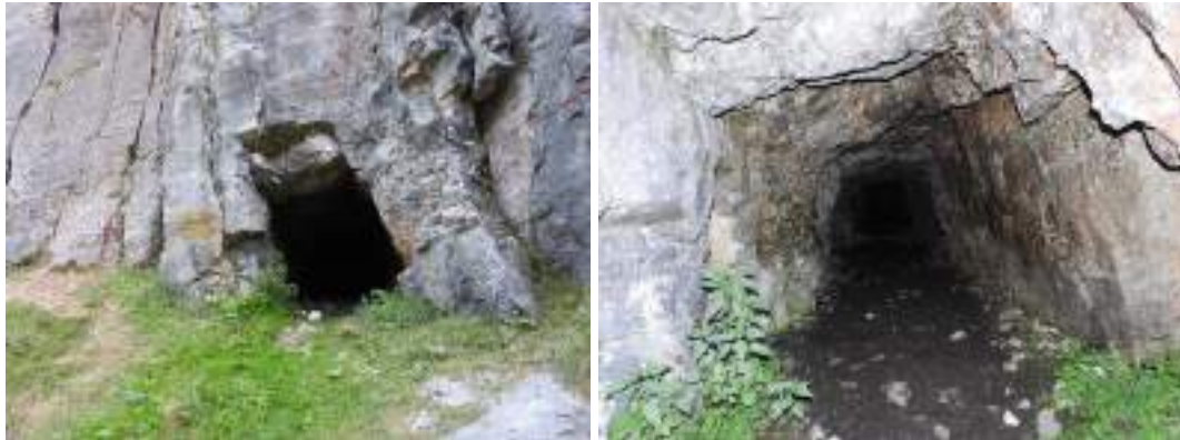
Fig. 26 Detalii galeria artificială nr. 1
