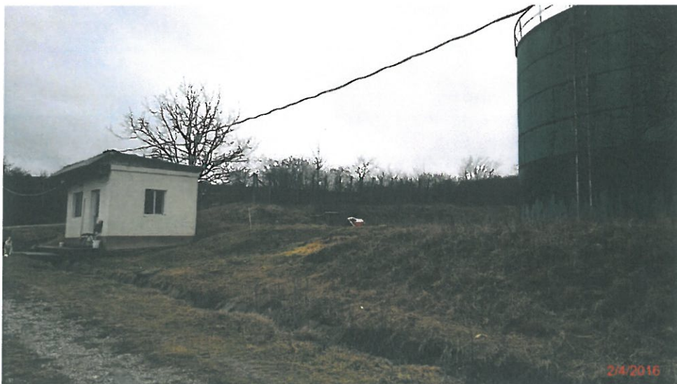
Fig. 2 – Casa poarta (C10), sant colector betonat si rezervor apa R7 (de la stanga la dreapta)
