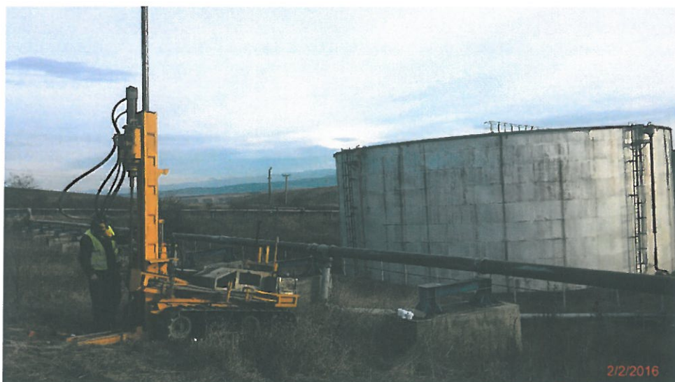
Fig. 18 - Instalatie de foraj folosita pentru punctul M2
