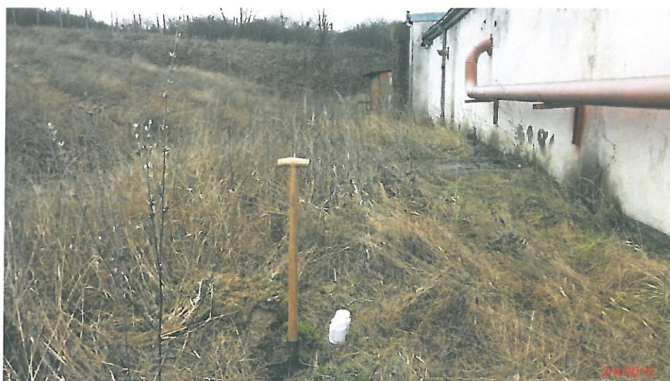
Fig. 35 - Amplasarea punctului P5 in vecinatatea punctului termic si a postului trafo (C12)
