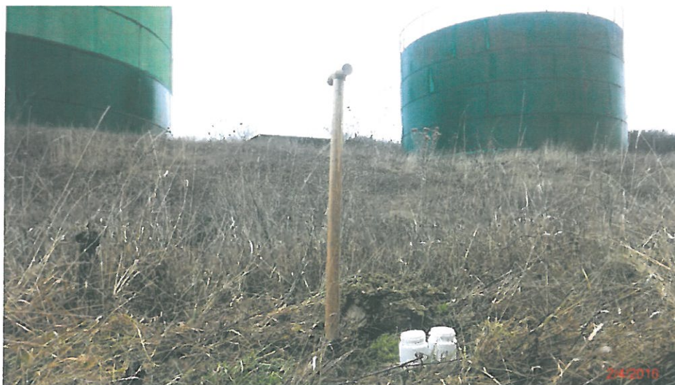
Fig. 36 - Vedere dinspre punctul P5 catre rezervoarele de apa R7 si R8 (de la stanga la dreapta)
