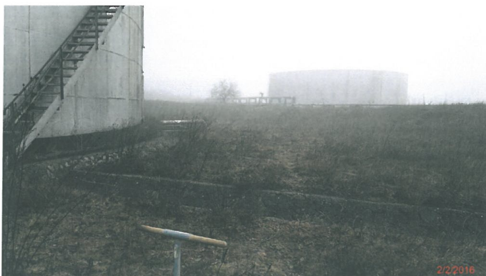
Fig. 44 - Sant colector betonat in vecinatatea punctului P9
