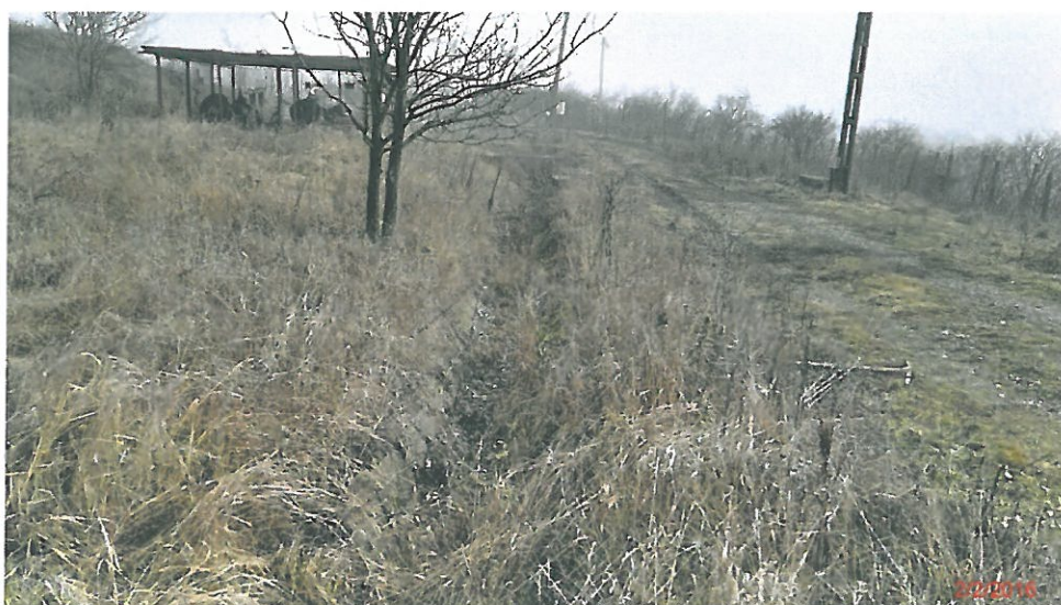
Fig. 6 - Sant colector betonat in jurul platformelor cu rezervoare
