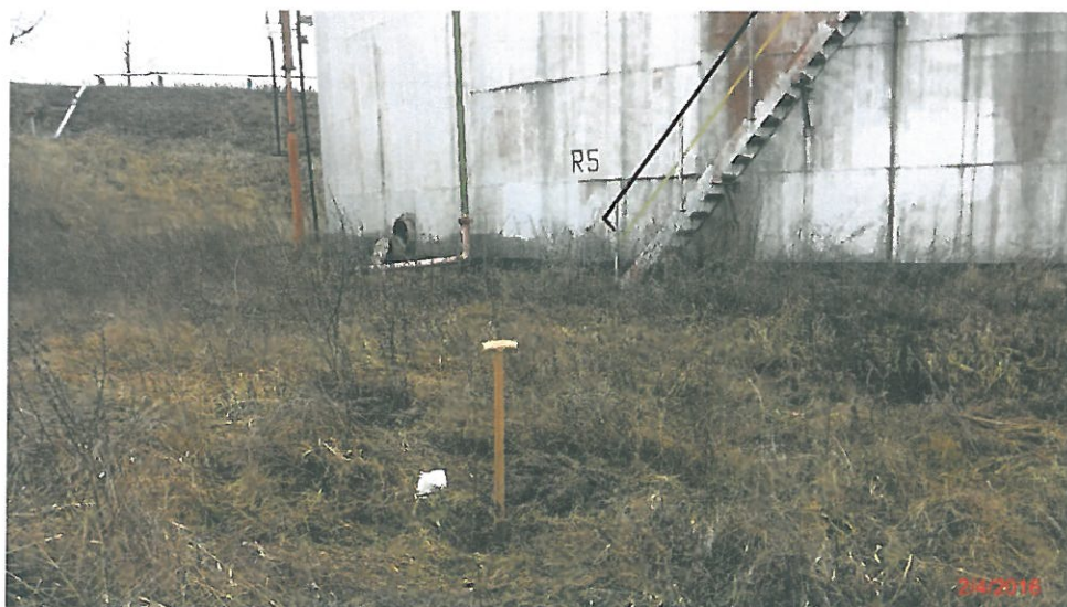
Fig. 31 - Punctul de prelevare P3 in interiorul platformei C1
