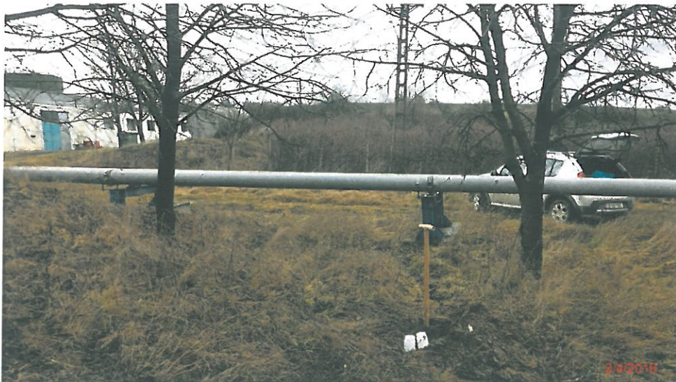
Fig. 40 - Amplasarea punctului P6 in vecinatatea drumului de acces, respectiv a conductei supraterane
