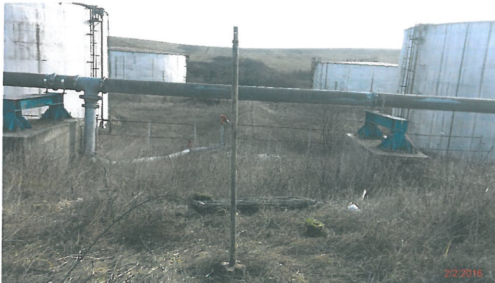
Fig. 17 - Amplasare foraj de monitorizare M2
