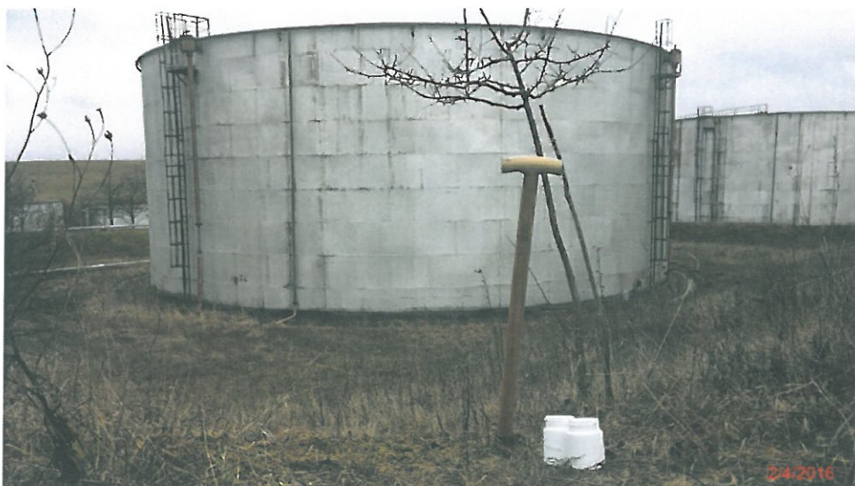
Fig. 29 - Punctul de prelevare P2 (vedere catre Sud-Vest)
