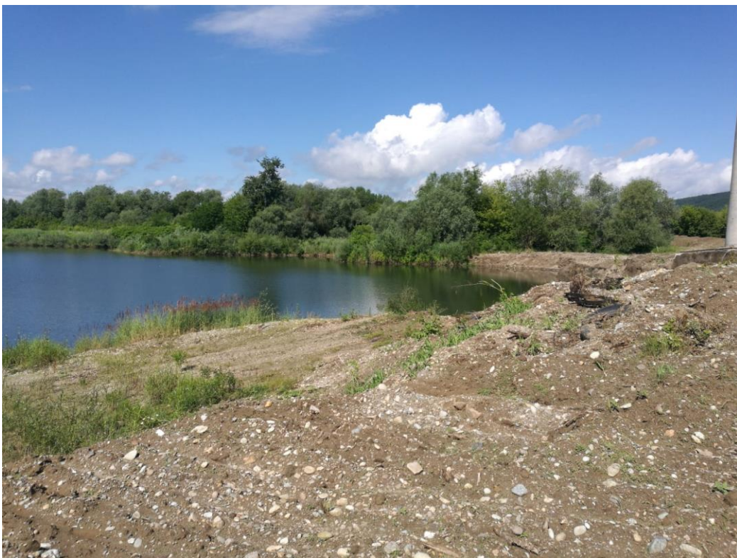
fig.9 Aspecte ale amplasamentului
