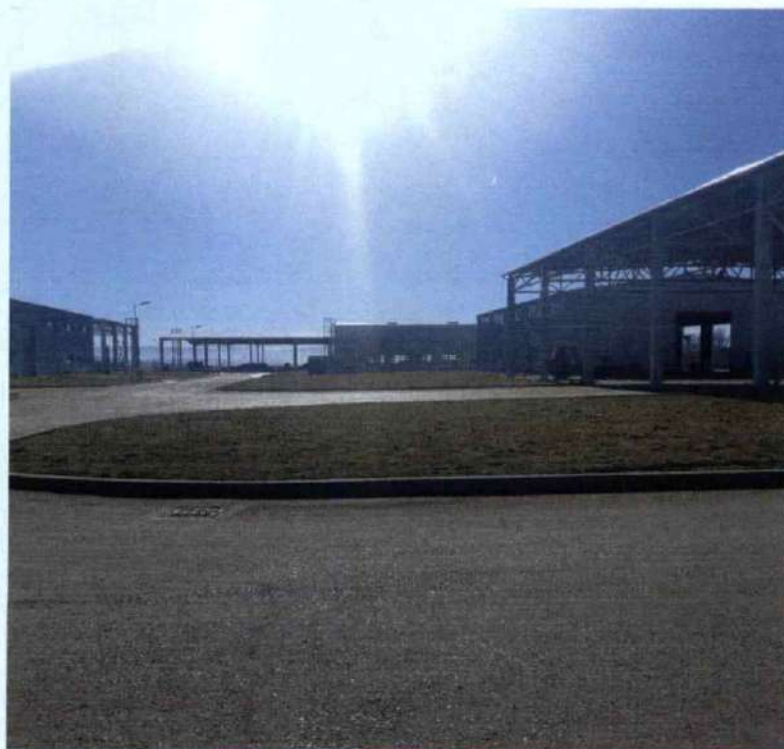
Fig.7. Zona receptie staita de tratare mecano-biologica.
