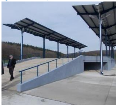
Figura 7-8 Stații deschise de transfer
