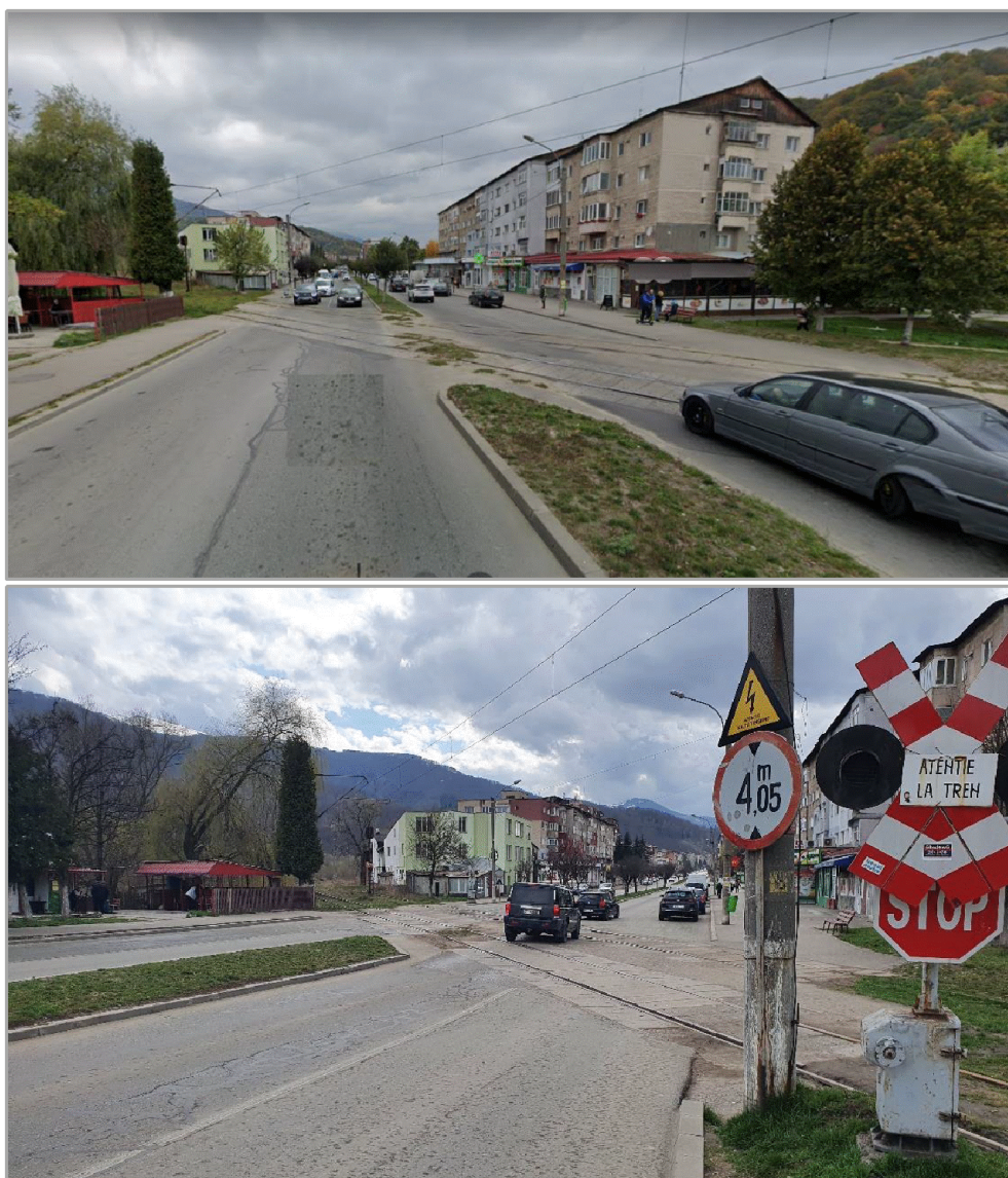
Figura 2.22. Intersecție la nivel între rețeaua rutieră și cea feroviară – Mun. Lupeni.
