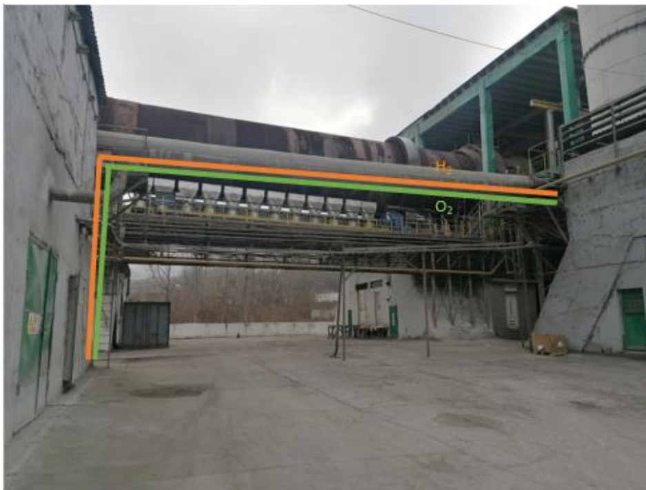
Amplasarea conductelor transport gaze H_2 și O_2
