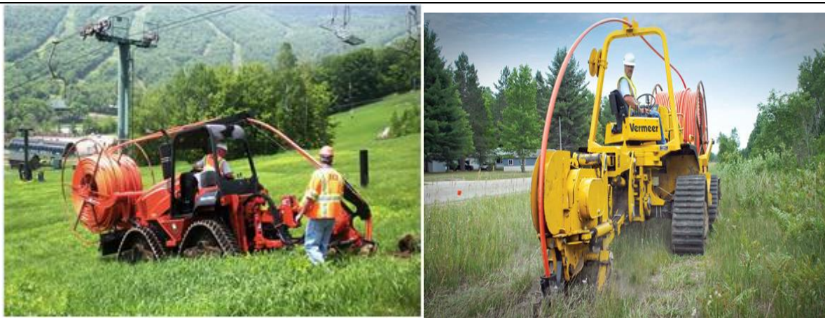
Figura nr. 1 - Utilaj specializat de îngropat fibră optică prin tub de protecție – în timpul montajului
