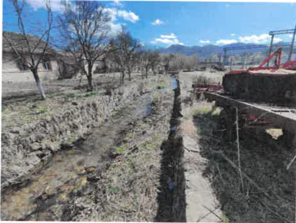
Foto 1. Zona amonte, având malurile protejate cu zidărie de piatră
