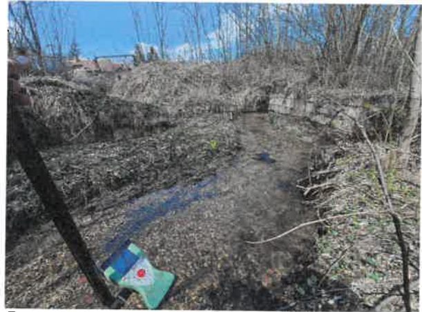
Foto 2. Zona podeț, având malurile protejate cu elemente prefabricate din beton
